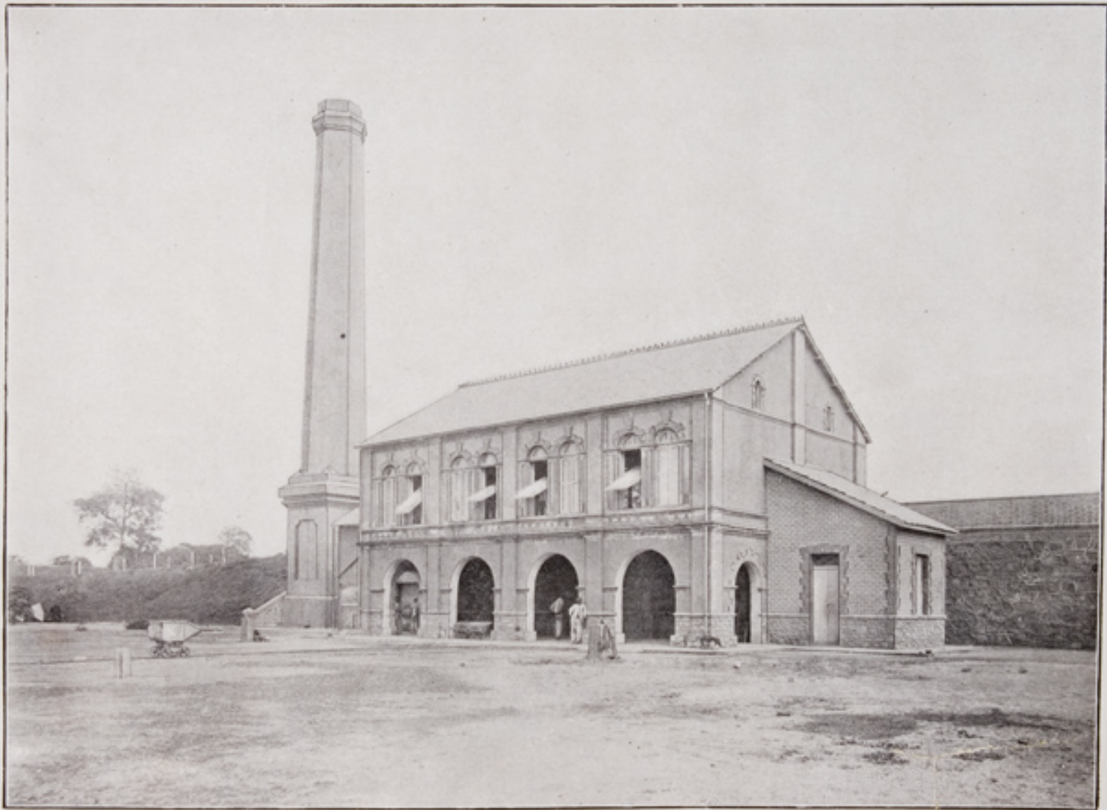
Pombal — Forno d'incineração de lixo
