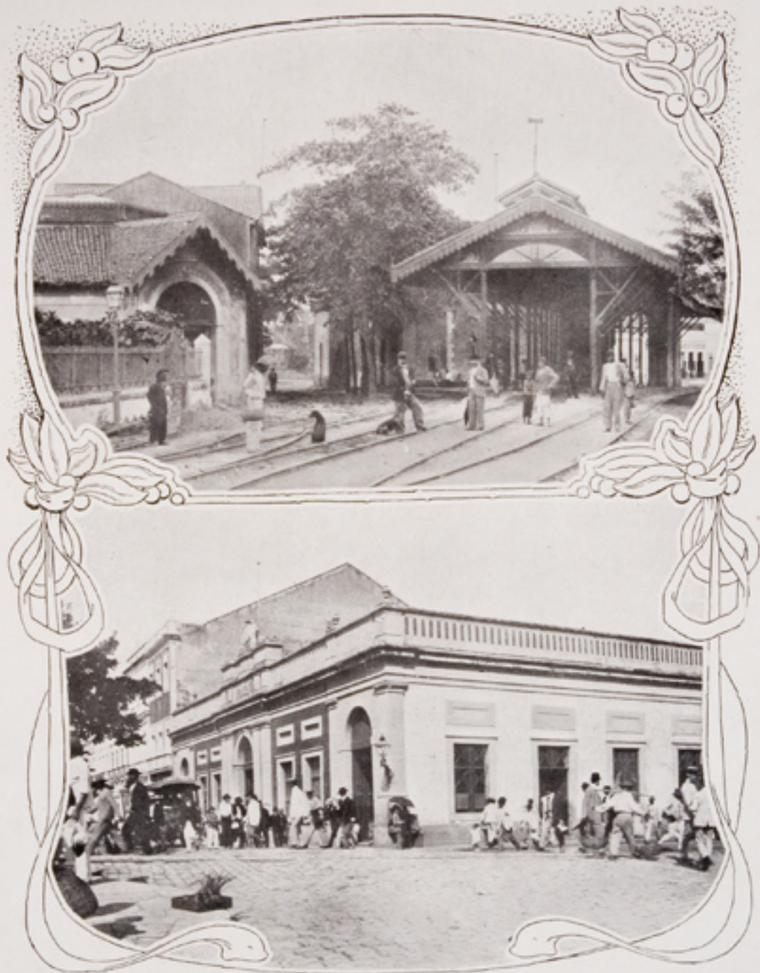
Encruzilhada e estação da Aurora — Estrada de ferro de Olinda Encruzilhada et gare Aurora — Chemin de fer de Olinda
