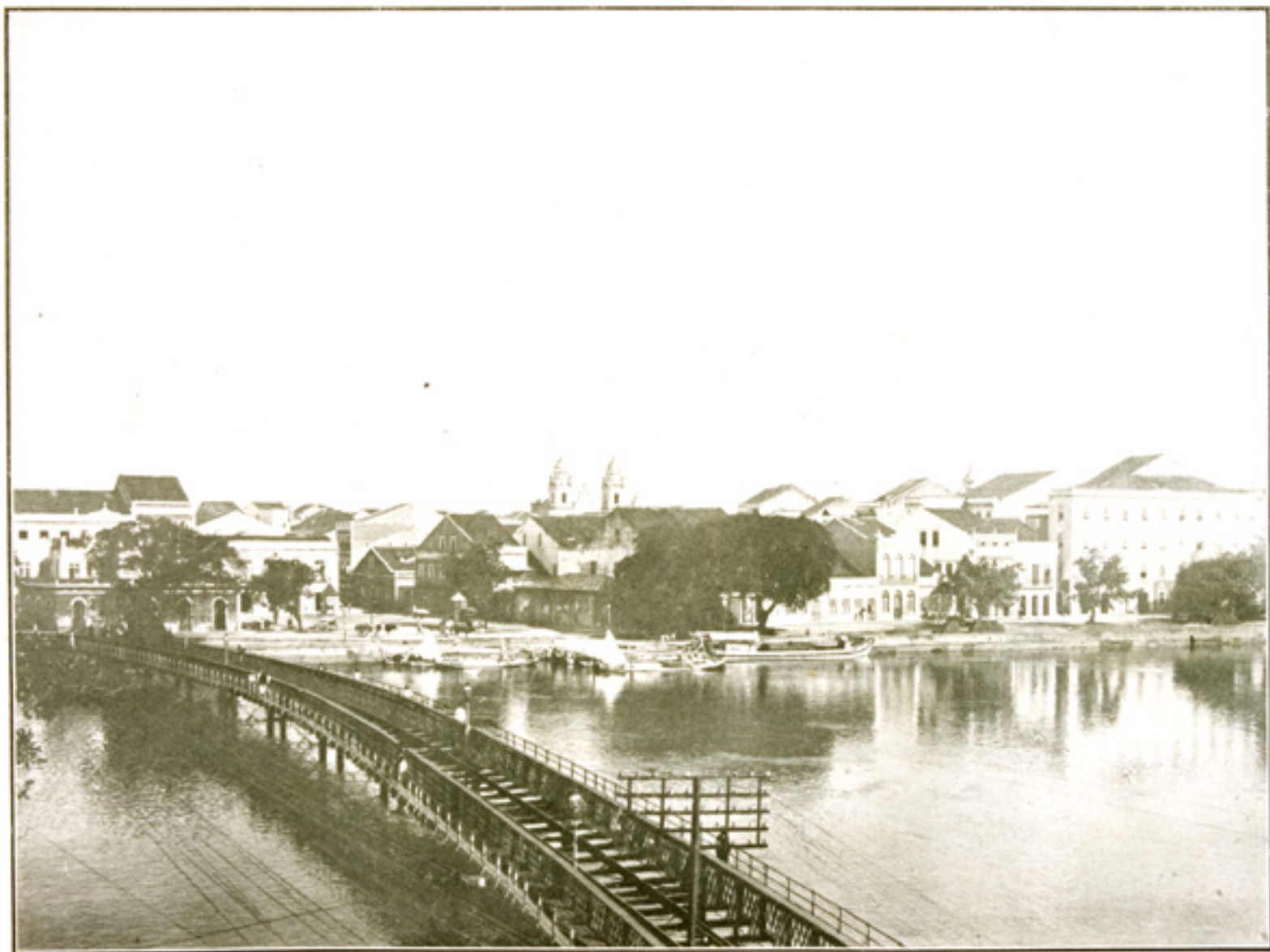
Rua do Sol — Ponte da via-ferrea de Caxangá
