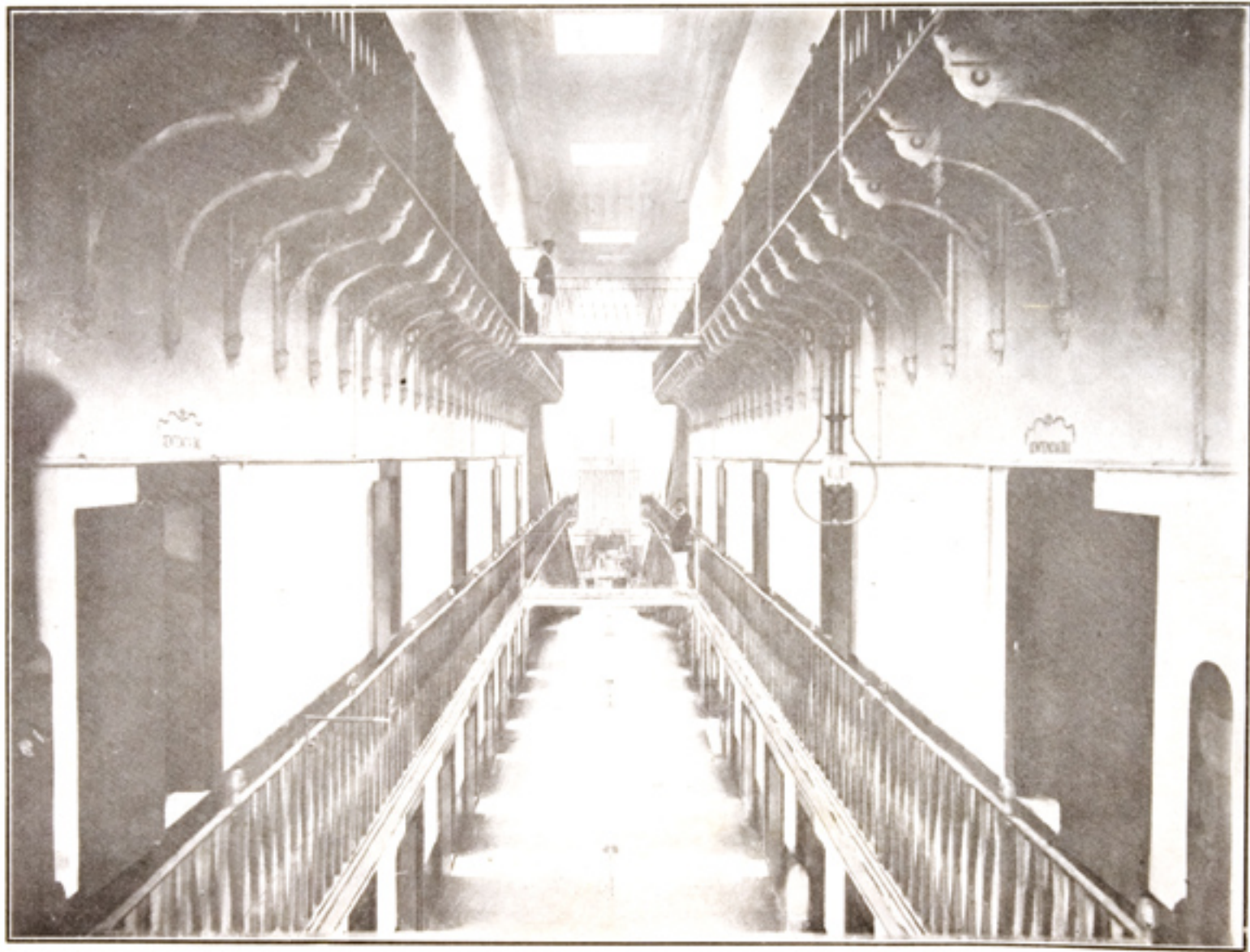
Interior da casa de detenção
