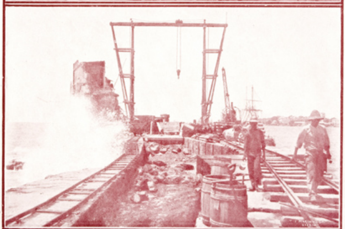
Obras do porto — A muralha
