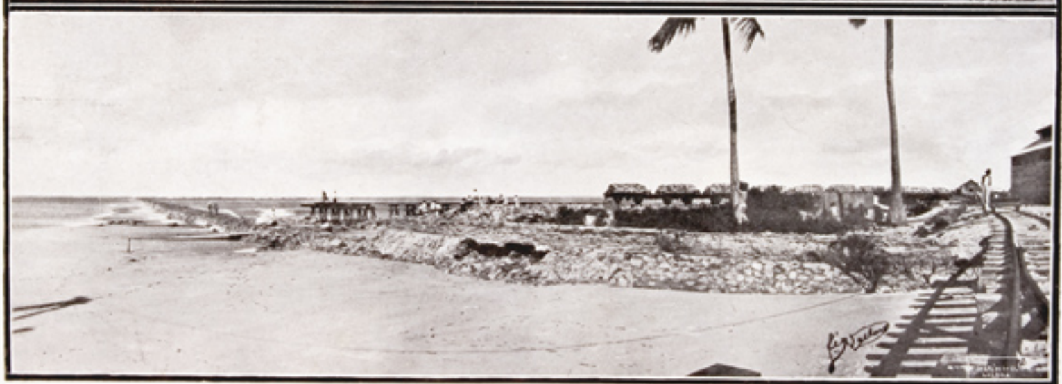
Pina e Olinda — Construção dos diques
