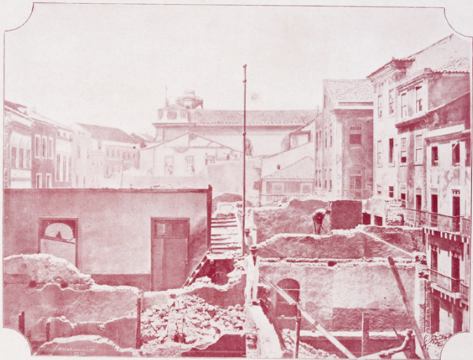
Demolições no bairro do Recife
